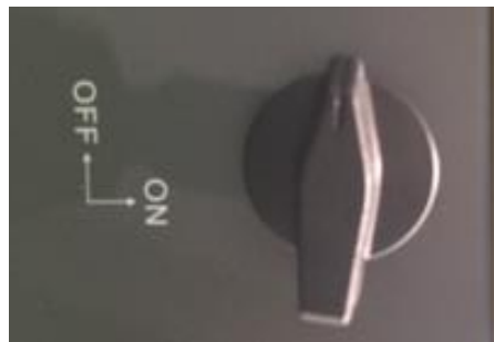
Figura 67 - Sezionatore fotovoltaico
